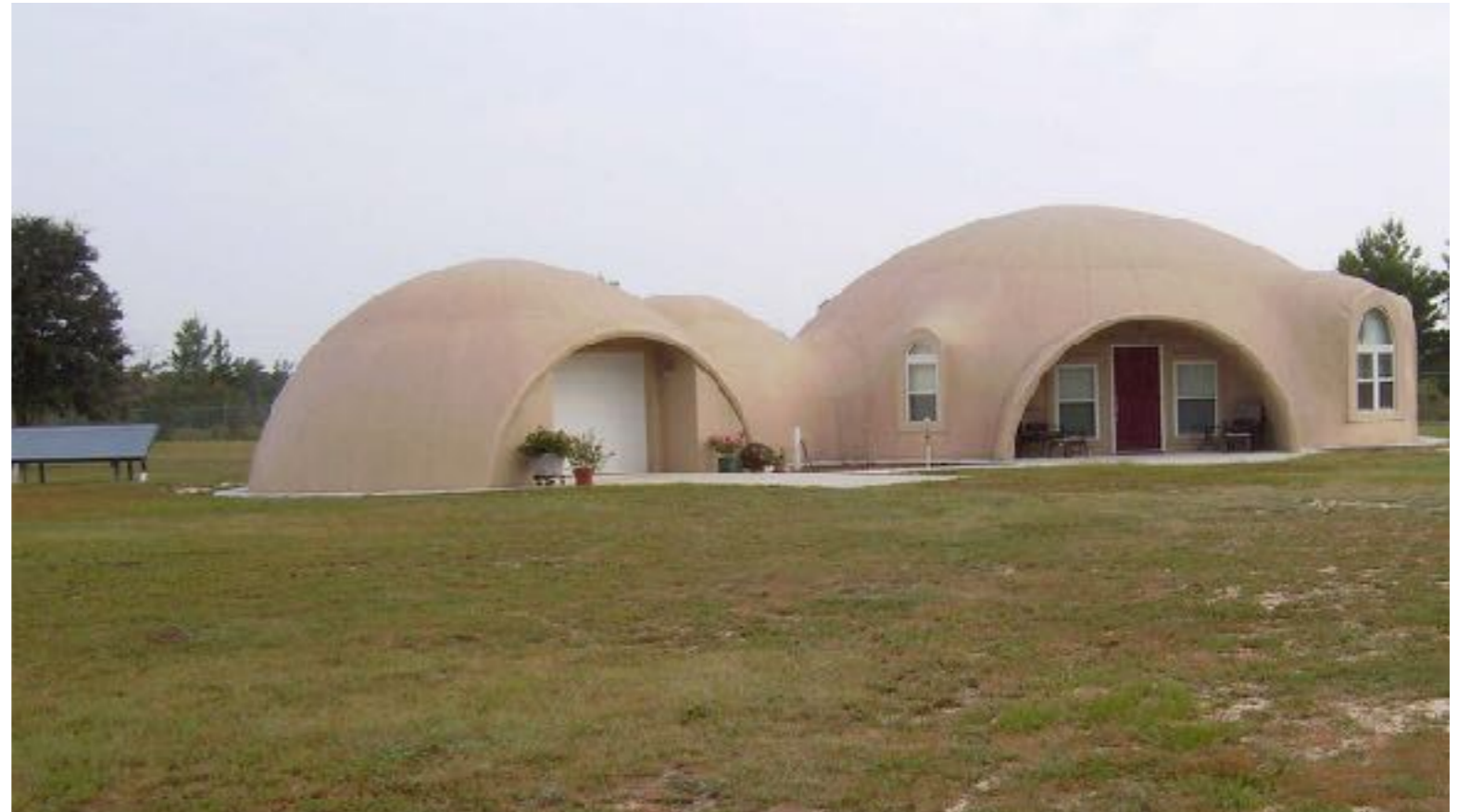
Los encofrados aéreos se pueden unir de muchas maneras creando espacios únicos.
